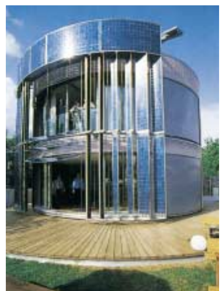
7 In der neuesten Solarhausgeneration wie etwa beim GEMINI-Haus in Weiz wird mit ein- und zweiachsig nachgeführten Solarmodulen Strom erzeugt. (Architekt: Erwin Kaltenecker, Weiz)
