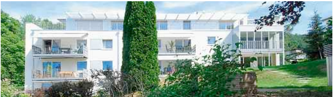
Nach der Sanierung: modern, leicht, einladend
