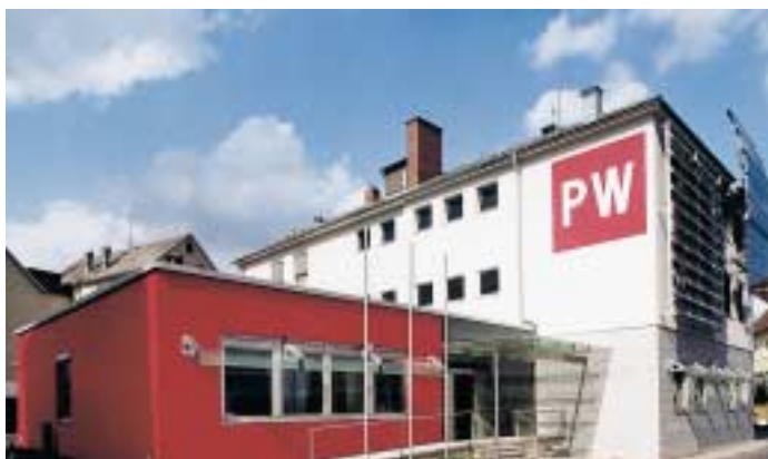
19–21 An der Südfassade der Pichler Werke GmbH wurde ein riesiger Solar-Vorhang installiert, der am Morgen um die Ecke fahren kann um auch die Solarstrahlung der Ostfassade zu nutzen. (Fotos: Harald Eisenberger, Graz)
