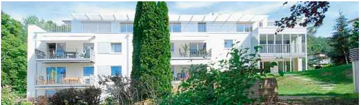
Nach der Sanierung: modern, leicht, einladend
