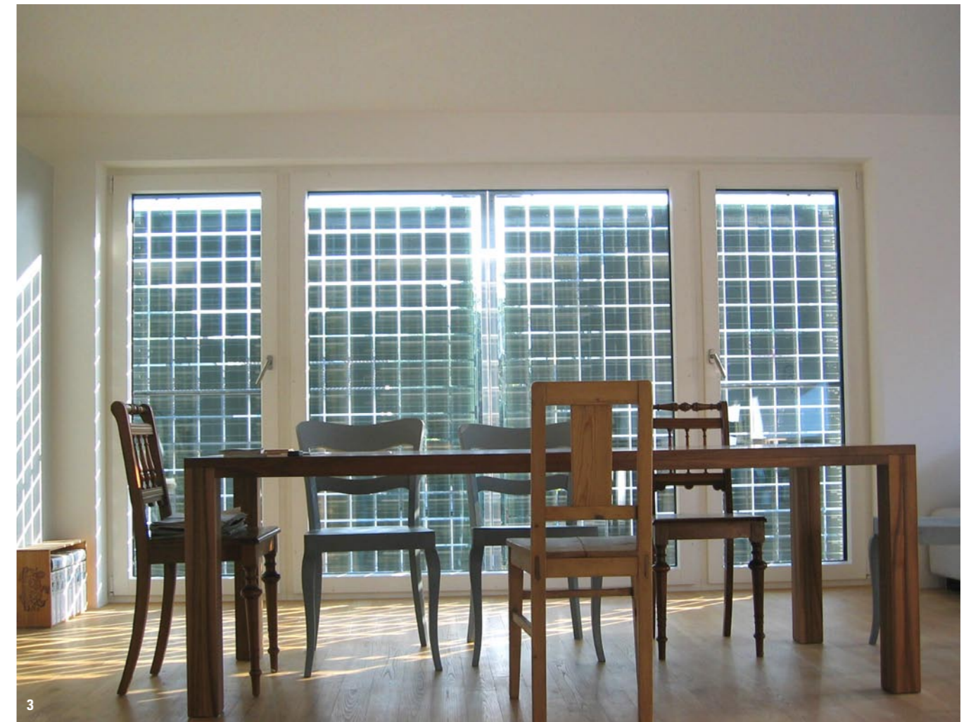
Zwei grosse Schiebeläden mit transparenten PV-Elementen schützen im Sommer vor Überhitzung und produzieren gleichzeitig Strom.
